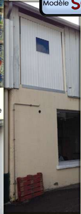
Barrière faisant office de porte bardée
