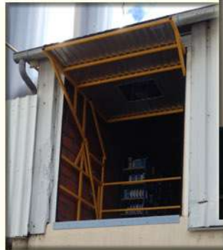
Barrière faisant office de porte bardée
