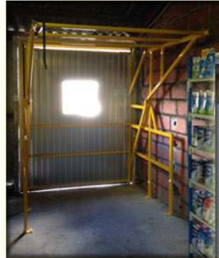
Barrière faisant office de porte bardée
