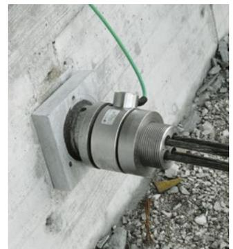
Fig. 2: HRL 4 (4 brins) monté sur un ancrage à câble
