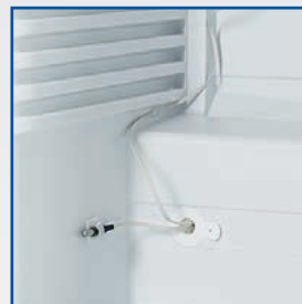
Passage de cuve Ø 15mm pour sonde GTC (Gestion Température Centralisée) PT100 ou numérique
